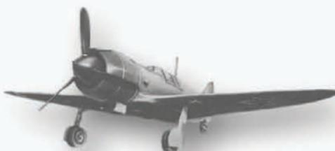
С первых дней Ла-5 отлично зарекомендовал себя в боях. Летчикам нравились легкость управления, маневренность самолета, достаточно высокая скорость. Вооружение (две пушки ШВАК калибра 20 мм) вполне устраивало воздушных бойцов. Звездобразный мотор воздушного охлаждения имел большую живучесть, чем мотор жидкостного охлаждения, и одновременно являлся для летчика защитой от огня противника с передней полусферы, хотя и ухудшал обзор впереди.
